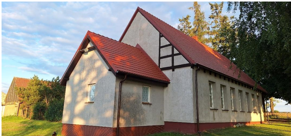
Fot. Sala wiejska w Buntowie – nowe pokrycie dachowe. Fot. Sołectwo Buntów.
