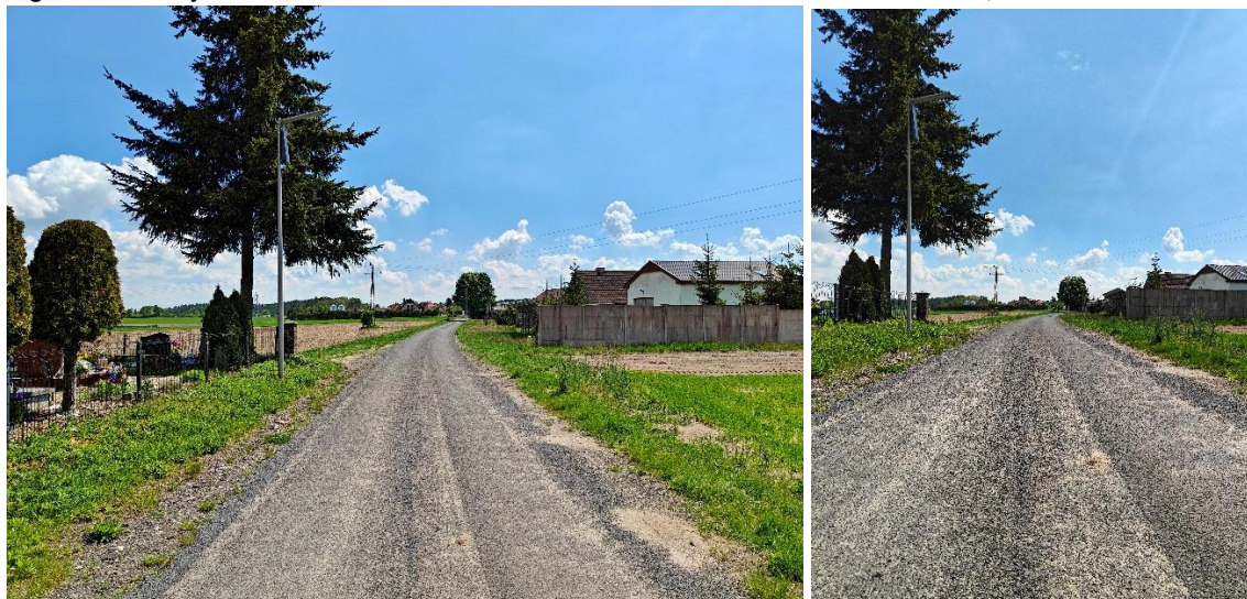
Fot. Droga „koło cmentarza” w Górznej – emulsjonowana. Fot. UG w Złotowie.
